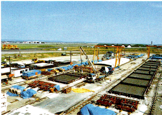
写真二 同上 PC版製作ヤード (PC版：7.5×7.5 m)
