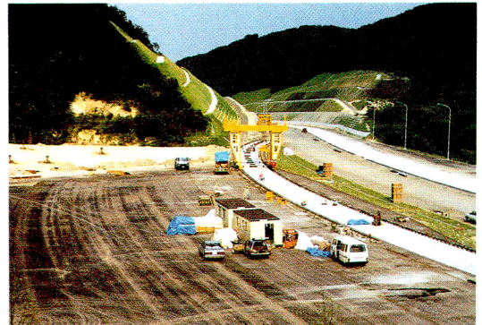
写真六 磐越自動車道試験舗装
