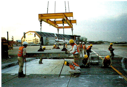
写真三 大阪国際空港エプロン改修工事
