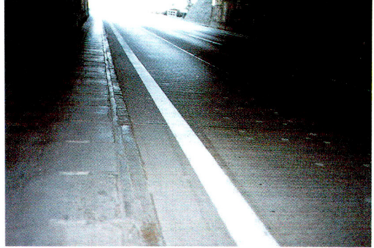
写真四 東山トンネル舗装打替え工事
