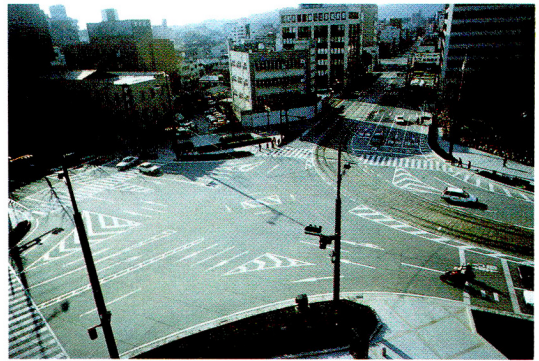
写真五 辛島町交差点整備工事
