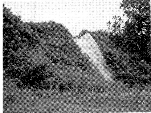
写真一 播種工からの樹林化・施工後2年
