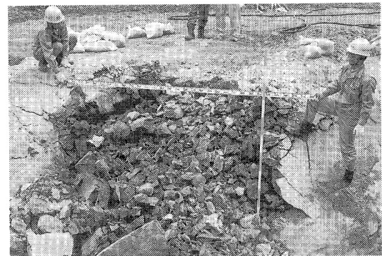
写真二 岩盤破碎例
