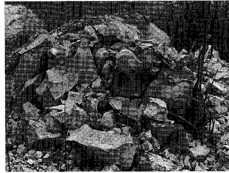
写真-1 原位置での泥岩のスレーキング状況
