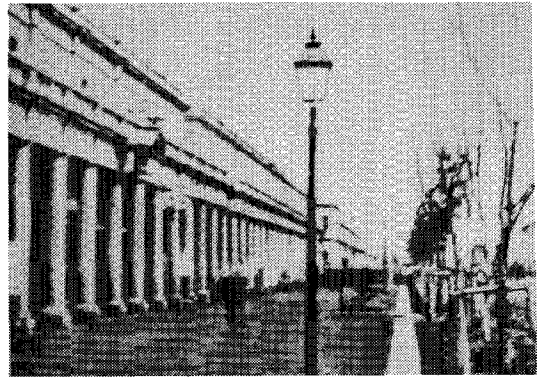
写真-1 竣工間もない当時の銀座通り
