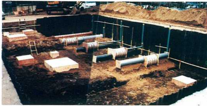
写真-3 モデル陥没空洞の敷設
