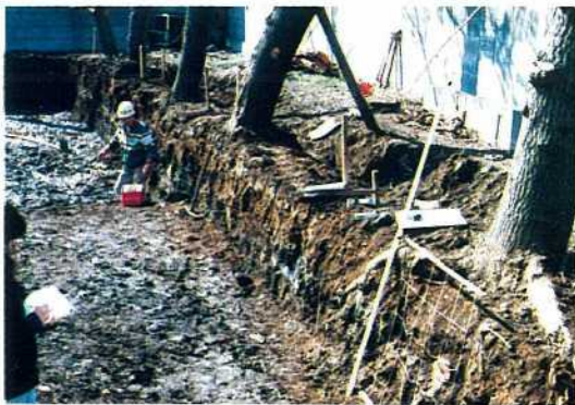
写真-4 キャブ設置に伴う改良路床土工事
