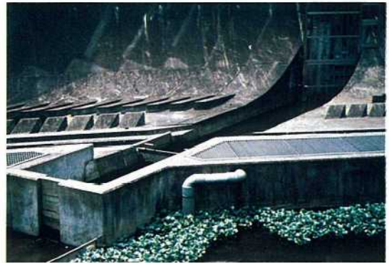
写真一八 浮上式礫間接触酸化処理施設 (石神井川音無橋)
