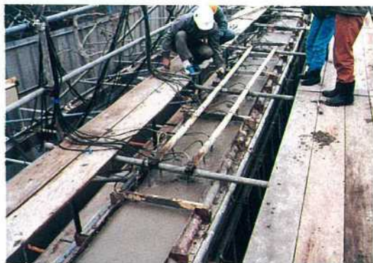
写真-5 RC 護岸に温度、ひずみ、応力センサーの埋設
