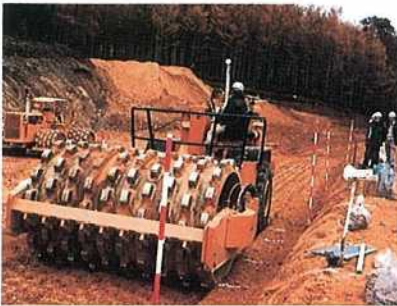
ダム予定現場付近で行った各種のローラによる、コア材の締固め方法に関する実験、検討
