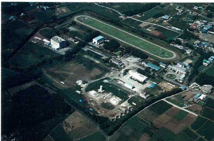
建設機械化研究所の全景（テストコースの直線部……長さ300m）
