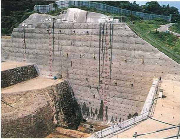
垂直で高さ25mに達する、鉄筋と吹付けを主とする山留め工の現地施工実験
