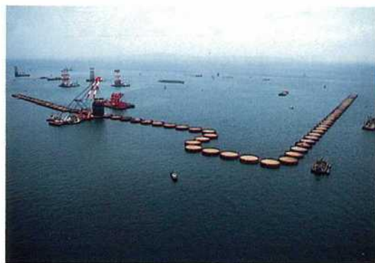
写真—1 根入れ式鋼板セル護岸施工全景
