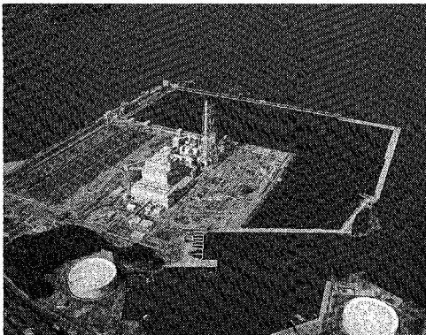
写真-1 建設中の松浦火力発電所
