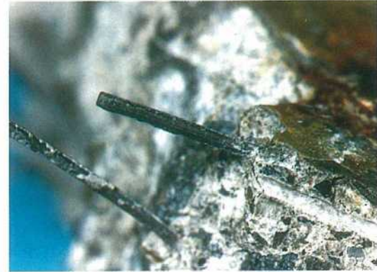
写真-4(b) コンクリート表面付近の鋼繊維の状態 [(a)の左端部の拡大]
