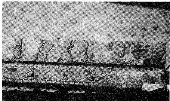
写真二 鉄筋近傍のひびわれ性状(側圧 0.5 f_c' )
