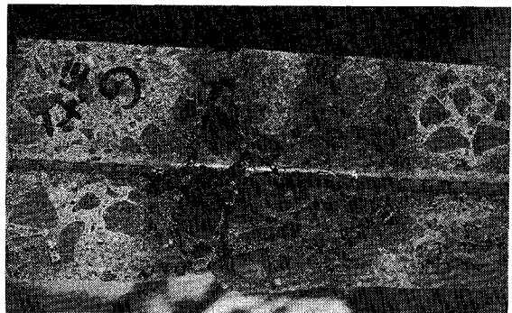
写真一 鉄筋近傍のひびわれ性状(側圧0)
