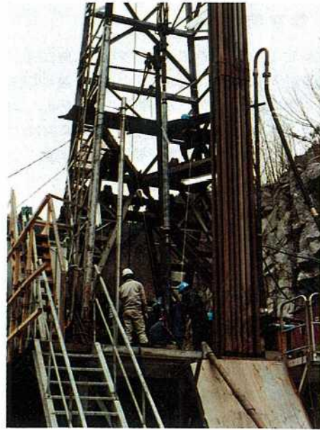
地震発生源（栃木県足尾）のボーリング現場
