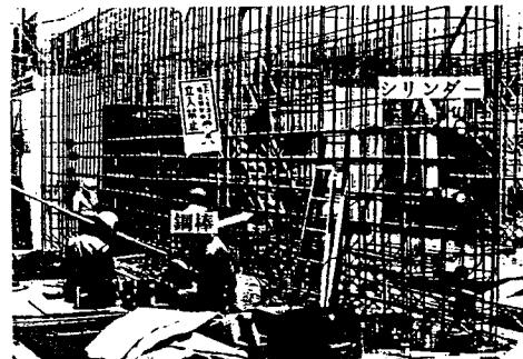
写真-2 鋼棒設置状況
