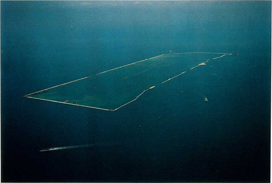
写真一 完成近い空港島外周護岸 (1989年4月)
