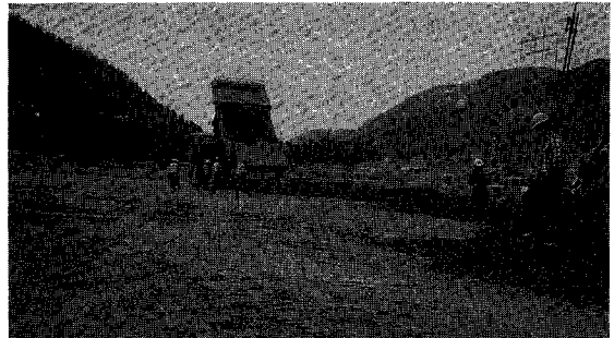
写真-7 Upper Stillwater ダムのスプレッダーによる敷均し
