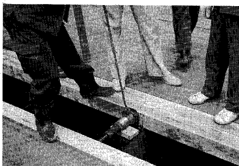
写真-12 床版パネルのほぞ組み
