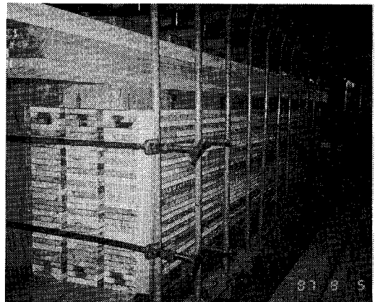
写真-2 接着積層後の加圧
