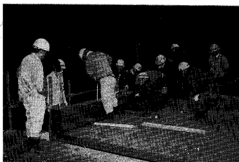
写真-13 笠木と床版のボルト結合
