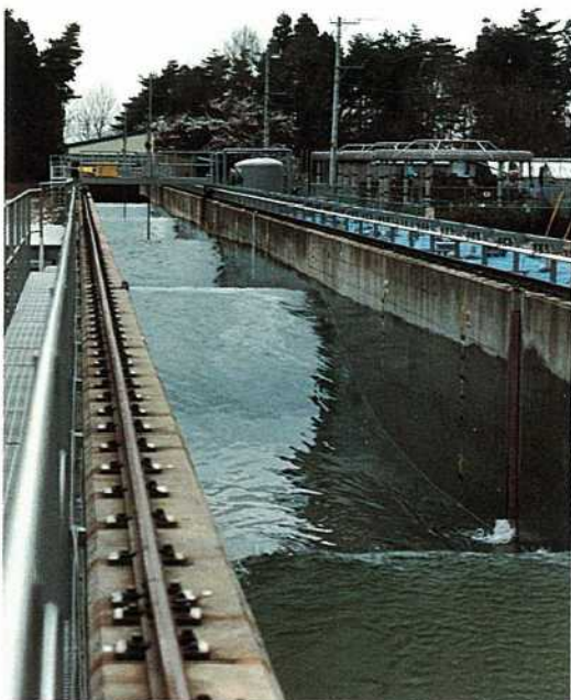
写真一〇 大型造波水路
