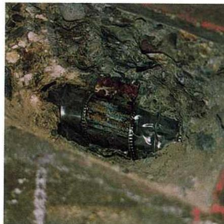
図一2 グラウト中に部分的な空隙がみられる状況
