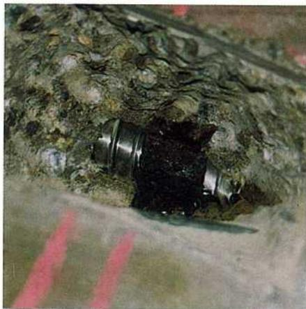
図一1 グラウトが十分に充填されている状況
