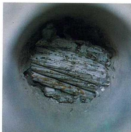
図一4 非充填部のPC鋼材の様子の例
