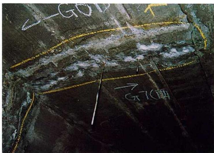
図一5 グラウト非充填による漏水部
