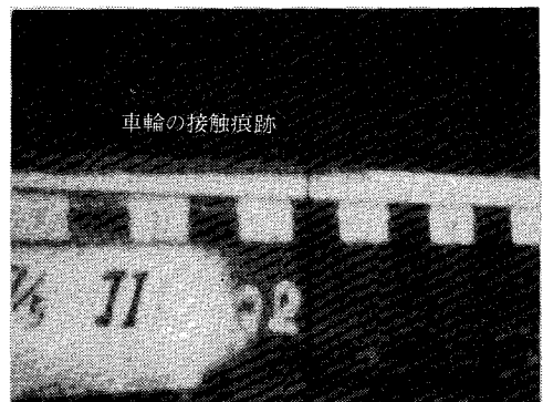
写真—3 車輪接触後のガードレール
