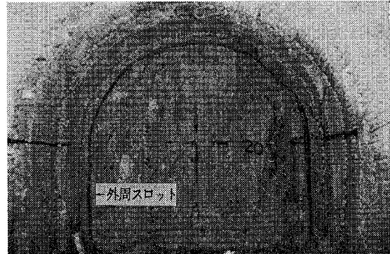
写真-2 外周スロット削孔状況
