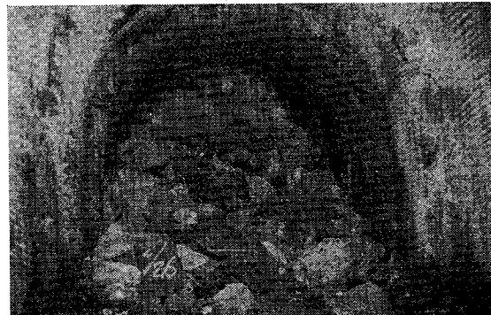
写真-5 外周スロット発破におけるずりの飛散状況
