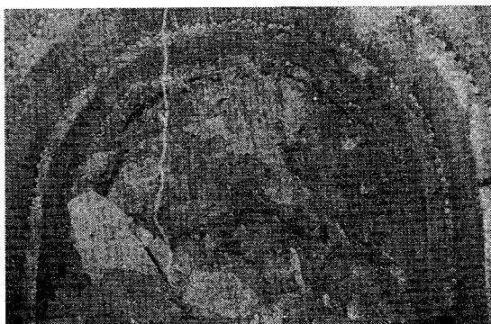
写真-4 心抜スロット発破におけるずりの飛散状況
