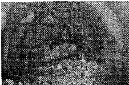
写真-3 通常制限発破におけるずりの飛散状況
