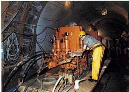
写真-5 竜飛先進導坑における注入状況
