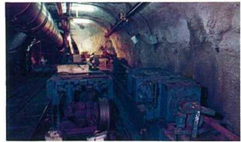
写真-7 吉岡先進導坑における先進水平ボーリング
