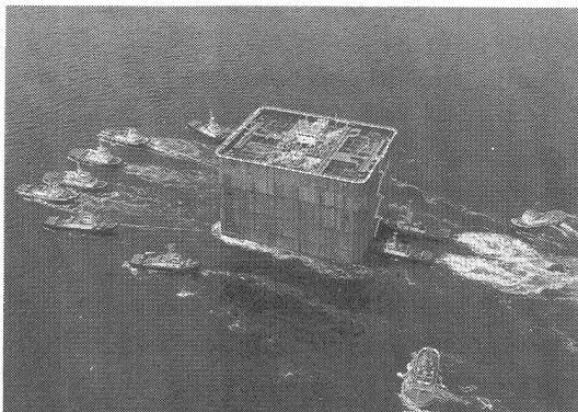
写真-4 ケーソンの曳航状況 (7A)
