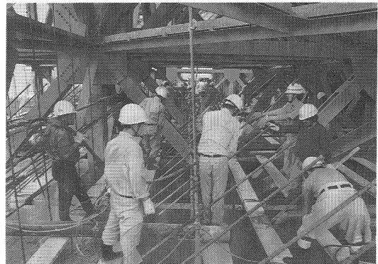
写真-13 アンカーフレーム内のコンクリート打設状況 (7A)
