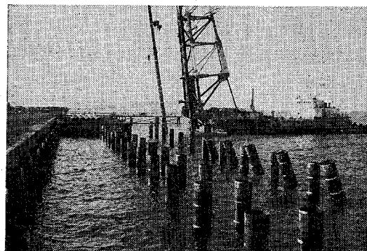
写真-4 重防食被覆钢管杭打設状況
