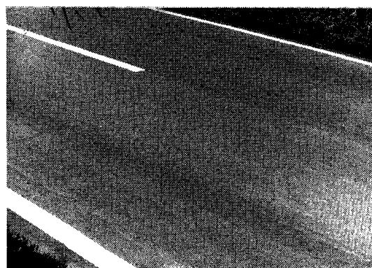
写真-1(a) ソイルセメント路盤を有する舗装の表面に発生したリフレクションクラックの全景／当現場は千葉県御宿地内の舗装路で、施工（夏）1年後の状態のもの。リフレクションクラックは、舗装面全幅にわたって横断状に発生している。
