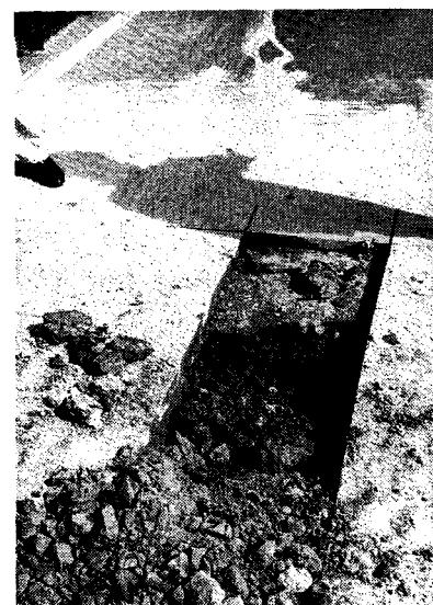
写真-1(b) 写真-1(a)におけるリフレクションクラック部の掘削調査／ソイルセメント路盤に発生したクラックが、当該路盤全厚（15 cm）に及んでいることがわかる（手前片側のみ掘削前）。
