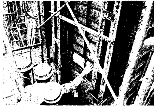
写真—2 打設時の状況
