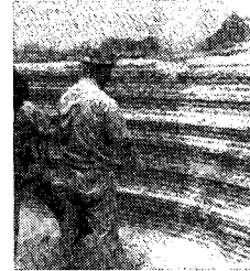
写真-2 直径 6 m 立孔の孔壁と孔底
