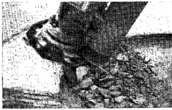
写真-1 アーム式掘削機の掘削状況とエアリフト用吸込み口
