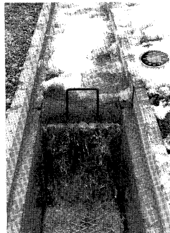
写真—2 底網による消融雪溝(米沢市の例)
