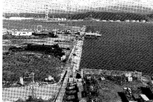
写真-8 室蘭港南防波堤(大正7～昭和2年建設, RC ケーン, 基部は護岸となっている)
