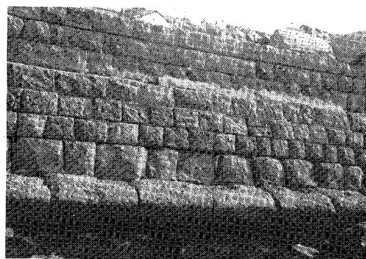
写真-5 函館漁港船入場防波堤（明治29～32年建設、基礎のコンクリートブロックは感潮部にあるが健全である）
