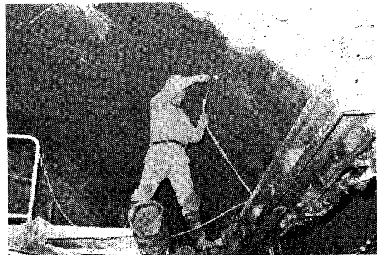
写真-8 トンネル現場における注入状況
