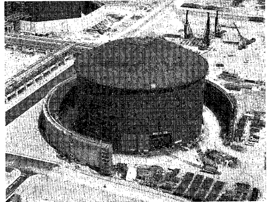
写真-2 PC 防液堤の近景
