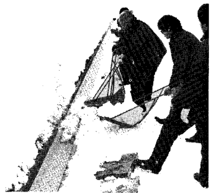
写真-1 現地での雪塊投入状況 (小出町・30 cm 溝)
