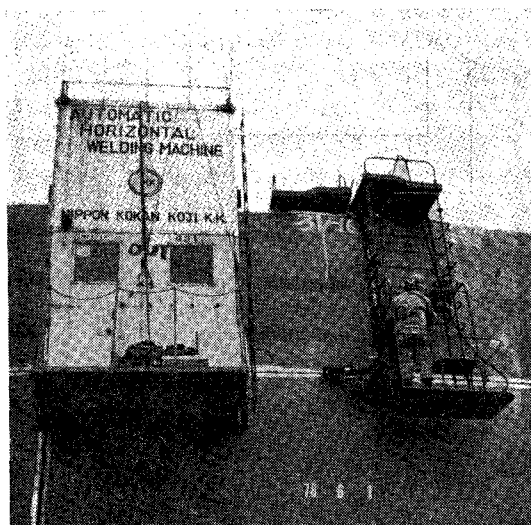
写真-8 側板-側板の水平継手の自動溶接
