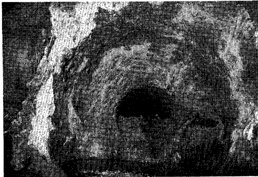
写真-1 TBM パイロット坑と全断面長孔発破の貫通
