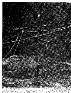
写真—3 さげふりを利用した 基準点の設定
