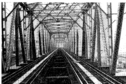
写真一 無道床式橋梁（枕木軌道）
