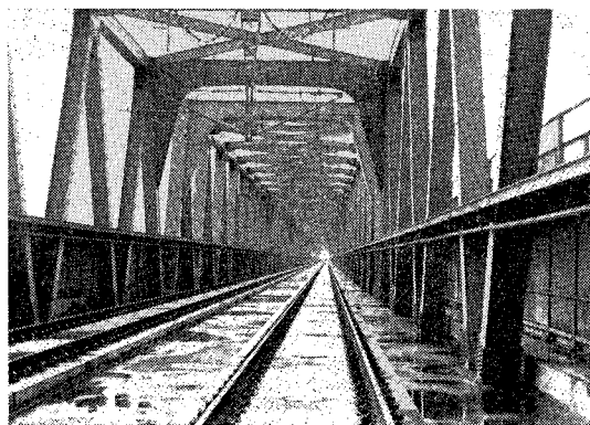
写真四 スラブ軌道式橋梁
