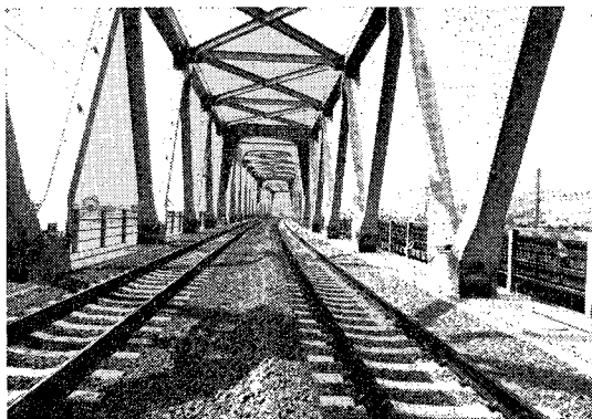
写真三 有道床式橋梁
