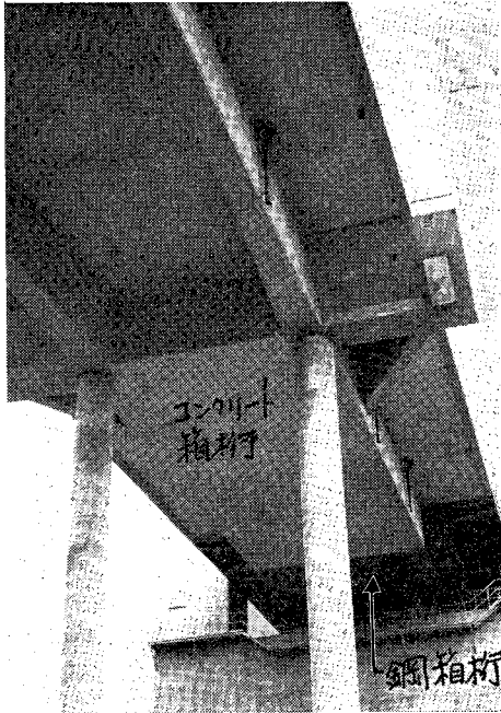
写真—1 Tjörn 橋のコンクリート桁と鋼桁の連結
