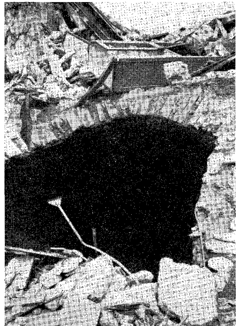
写真-2 南イタリア地震（1980）におけるラビアーノ町のアーチ構造物の被害状況（その1）
