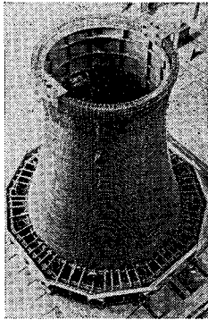
写真一 配筋状況
