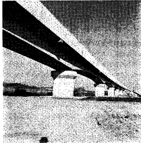
山陽新幹線芦田川橋梁 (広島県)
