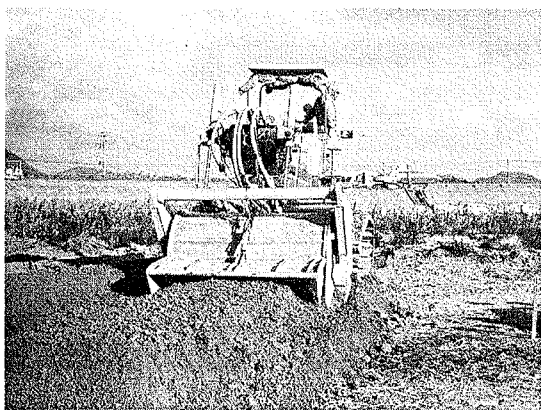
写真-6 スタビライザーによる混合状況
