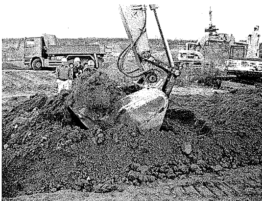
写真-8 バケット・ミキシングによる混合状況
