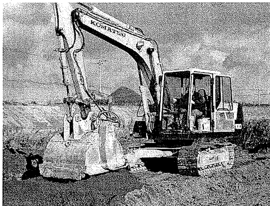
写真-7 バックホウ・スタビライザーによる混合状況
