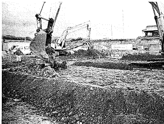
写真-4 バケットによる底泥土の撒出し状況
