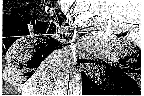
写真-1 松坂現地実験:試掘状況
