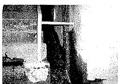
写真-3 堤体縫目からの漏水
