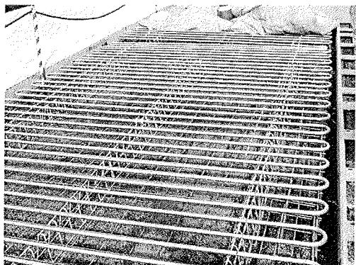
写真-1 パイプヒーティングにおけるパイプ配置例
