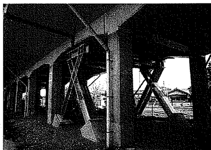
図-25 X型補強工完成写真
