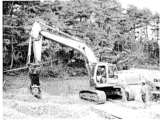
写真一2 トレンチャー型攪拌混合機による初期固化状況
