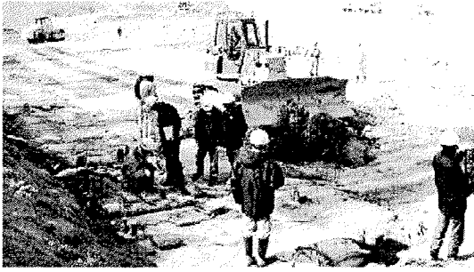
写真-2 宅地造成現場での土のう積層体を用いた防振工の施工の様子
