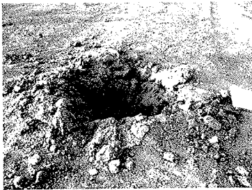
(a) 爆破後の孔の状況
