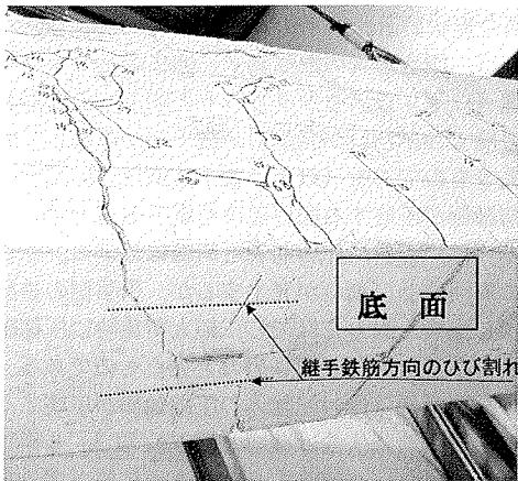
写真-1 継手破壊した試験体底面のひび割れ状況
