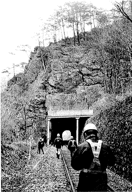
写真-2 検証例-2の状況
