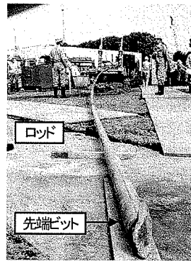
写真-1 先端ビット及びロッド
